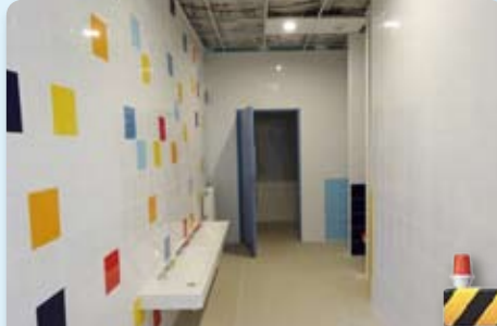
Travaux de l'école maternelle
