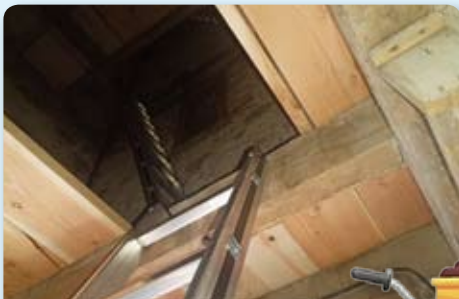
Église : Réfection accessibilité au clocher
