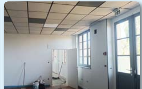
Travaux école de musique avant déménagement
