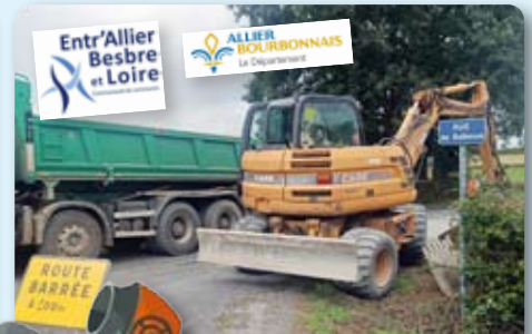
Travaux de voirie
