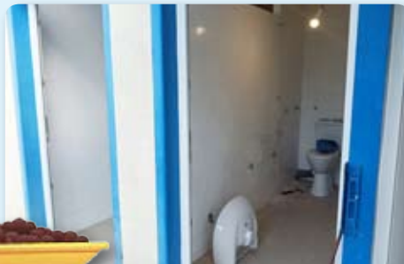
Travaux vestiaires de rugby
