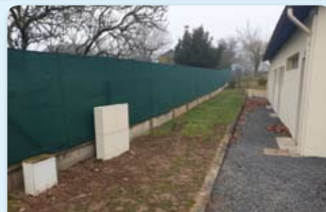
Sécurisation électrique du rugby
