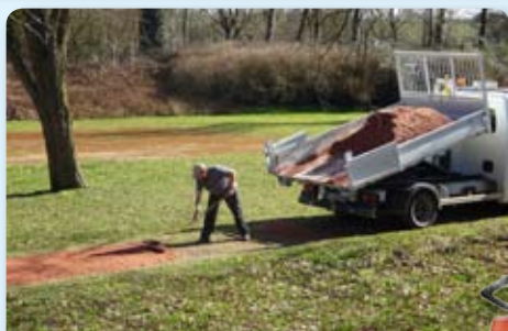
Réfection des chemins au Parc des Percières
