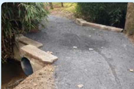
Réfection du passage du Parc de la Roseraie
