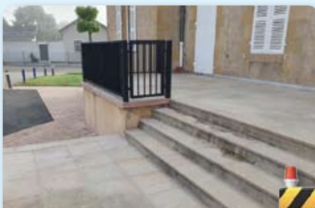
Réparation et nettoyage de la terrasse derrière la Mairie
