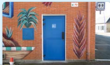
Remplacement de la porte des toilettes extérieures de la salle Laurent GRILLET
