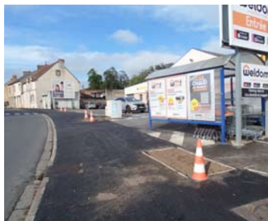
Réhabilitation de trottoirs en 2024
