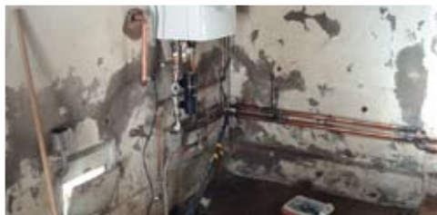
Rénovation de la chaudière du Site George SAND
