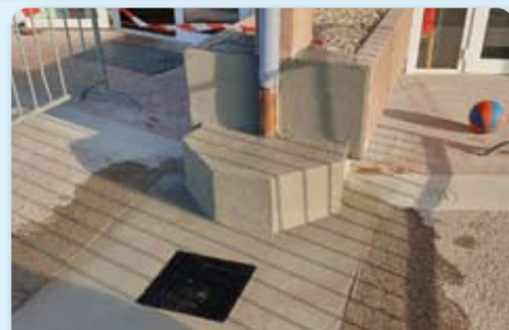
Modification à l'entrée de l'Accueil de Loisirs
