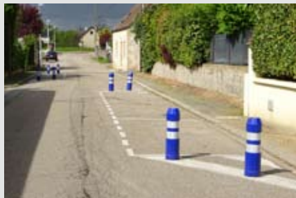
► Potelets sur places de stationnement dans la Rue des 5 noyers
