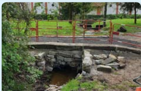
Restauration du pont du Parc de la Roseraie
