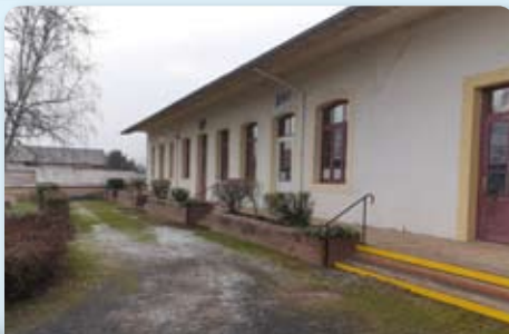
Rampes de sécurité à la Médiathèque
