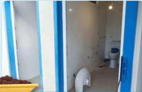
Travaux vestiaires de rugby
