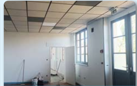
Travaux école de musique avant déménagement
