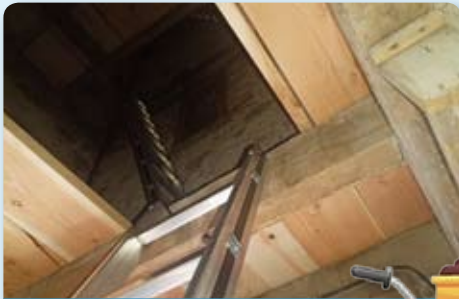
Église : Réfection accessibilité au clocher
