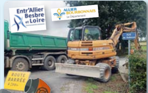
Travaux de voirie
