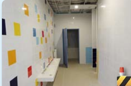
Travaux de l'école maternelle
